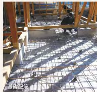
無筋の基礎だったため、外周部とベース部分にすべて配筋をしてベタ基礎に。増築部分には地盤改良工事をおこない、沈下しないように工夫しました。
