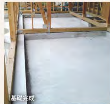
無筋の基礎だったため、外周部とベース部分にすべて配筋をしてベタ基礎に。増築部分には地盤改良工事をおこない、沈下しないように工夫しました。
