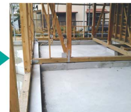
無筋の基礎だったため、外周部とベース部分にすべて配筋をしてベタ基礎に。増築部分には地盤改良工事をおこない、沈下しないように工夫しました。
