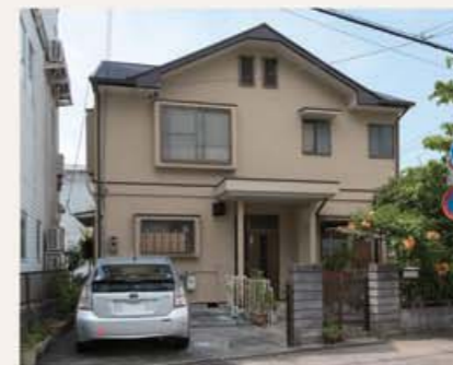
●屋根:塗装(シリコン) ●外壁:塗装(水性シリコン) 浜松市中区 N様邸
