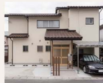
●屋根:葺替え(ルーガ) ●外壁:塗装(水性シリコン) 浜松市浜北区 N様邸
