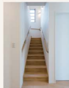
これからの暮らしを考え、ゆるやかな勾配に設計した階段。手摺りは両側に取付。
